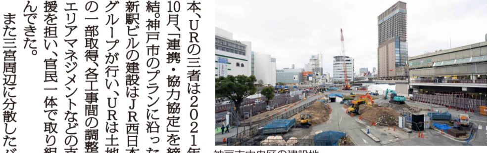
神戸市中央区の建設地
